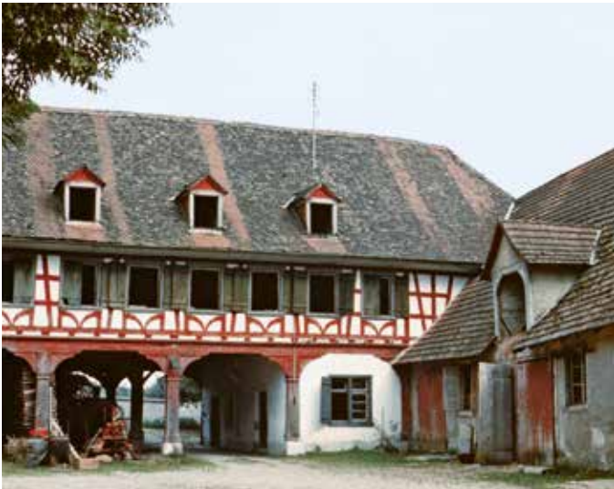
Vor 1977 Bei Stiftungsgründung waren die Kornschütte und die Stallungen in einem desolaten Zustand.
