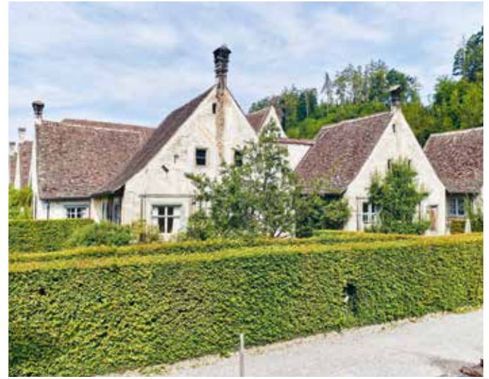
2024 Blick auf die sorgsam restaurierten Klausen. Heute verbringen Gäste darin «Ferien im Baudenkmal». Die nicht mehr vorhandenen Ummauerungen der einzelnen Mönchsklausen wurden mit Hagebuchenhecken nachgebildet.
