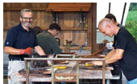
Thomas Meienberger, Leiter Bau mit tatkräftiger Unterstützung beim Putzen der historischen Ziegel
